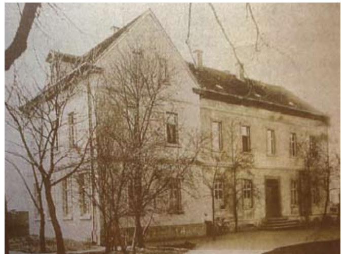
Schule 1878 mit Anbau von 1898
