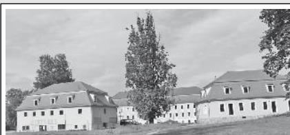
Das Rittergut zeigt sich nach fast abgeschlossener Sanierung von einer seiner schönsten Seiten.
